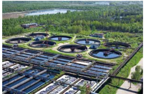
Tratamiento de aguas residuales
